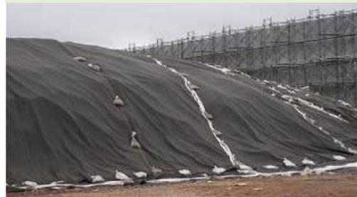
悪臭防止、雨水による発酵抑制のためのキャッピングシート敷設 宮城県石巻市
