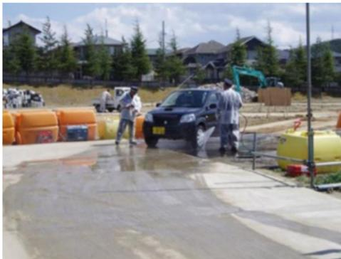
写真 4-1-8 高圧洗浄機によるタイヤ洗浄
