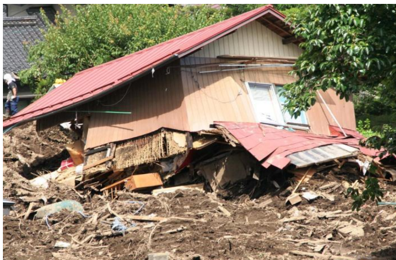
一見して住家全部が倒壊している例
